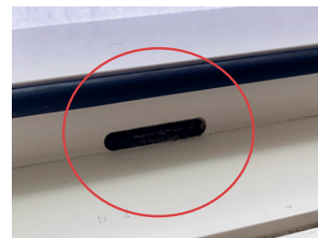
Afbeelding ontwatering sleuf binnenzijde.
