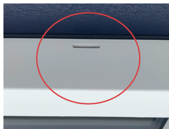
Afbeelding ontwatering sleuf buitenzijde.
