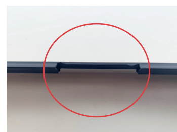
Afbeelding beluchting dmv rubberdichting onderbreking.
